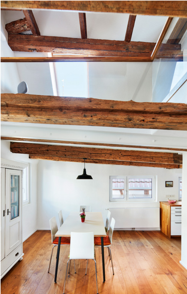
Mehr Kopffreiheit: Statt geschlossener, „drückender“ Decken erlauben die offenen Balkenkonstruktionen einen Durchblick bis in den First.
